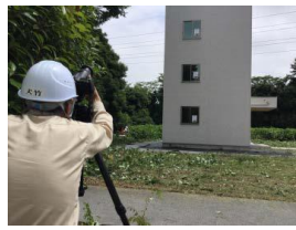
②地上撮影点検（カメラ撮影）
