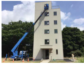
①高所作業（目視点検）
